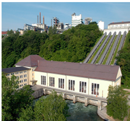
Die Alzwerke versorgen den Standort Burghausen seit 1922 mit elektrischer Energie aus Wasserkraft
