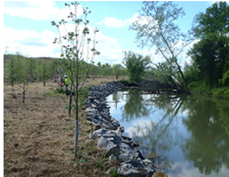
Die Renaturierungsarbeiten am South Mouse Creek geben zahlreichen Tier- und Pflanzenarten am Standort Charleston einen natürlichen Lebensraum.
